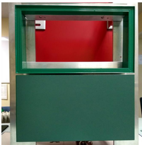
Рис.3. Технология устройства тонколистового керамогранита с применением обрезанного рамочного профиля.
